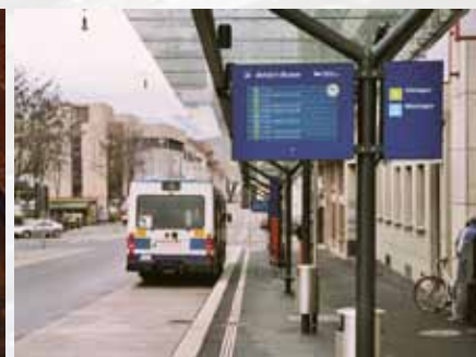
Bus Terminal Zugo / Svizzera
